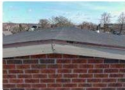
Photo 102 · F1, F8 End wall, rake & perimeter
