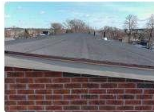
Photo 103 · F1 End wall, rake & perimeter
